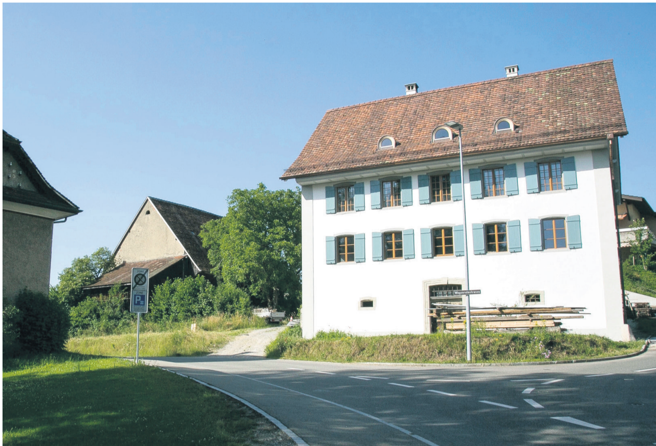
Für die Eidgenossenschaft von Bedeutung: Nach der Villa Isler steht nun mit dem imposanten Seckelmeisterhaus an der Steingasse (Bild) ein zweites Gebäude in Wohlen unter nationalem Denkmalschutz.
