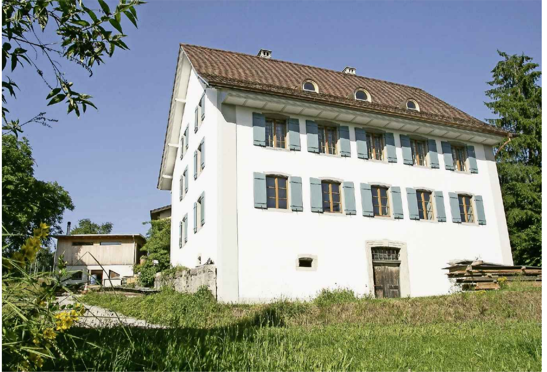
Die Aussensanierung des historischen Seckelmeisterhauses an der Steingasse 47 in Wohlen ist weitgehend abgeschlossen.
