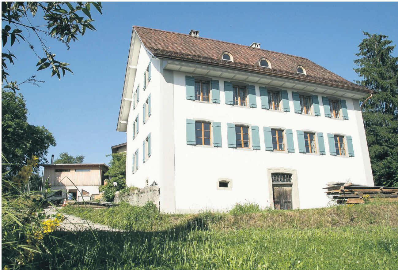
Neues äusseres Erscheinungsbild erhalten: Das imposante Seckelmeisterhaus erscheint seit ein paar Tagen und nach dem Abbau der Gerüste in einem prächtigen Gewand.
