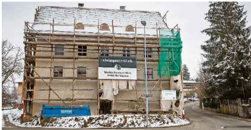
Solche Stangengerüste aus Holz waren ab Mitte des 18. Jahrhunderts üblich.
